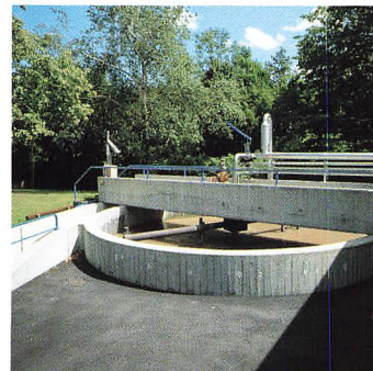
DER BELÜFTETE RUNDSANDFANG
